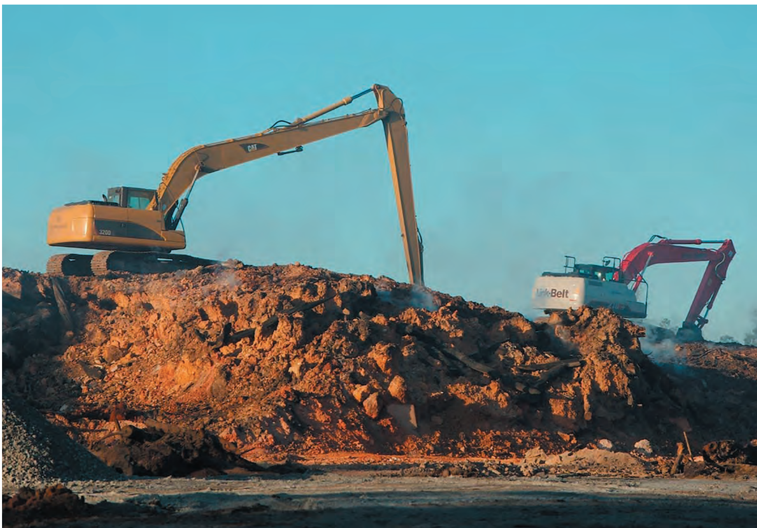
Рис. 12. Добыча материала для заполнения траншей и перекрытия кислорода, январь 2023 г. Источник: https://www.al.com/news/birmingham/2023/01/epa-strategy-for-alabama-landfill-fire-smother-it-in-dirt.html
